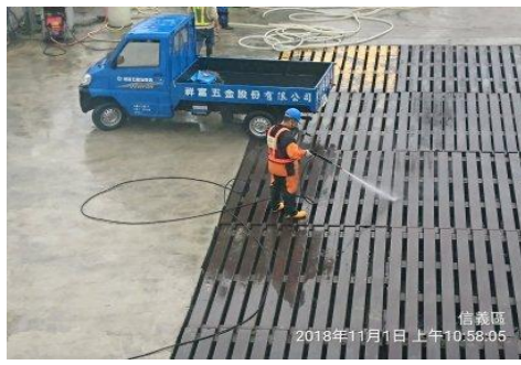
說明:路面鋪設混凝土及洗車台
