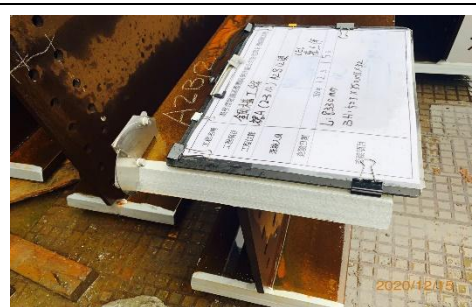
說明：鋼骨進場查驗完成
